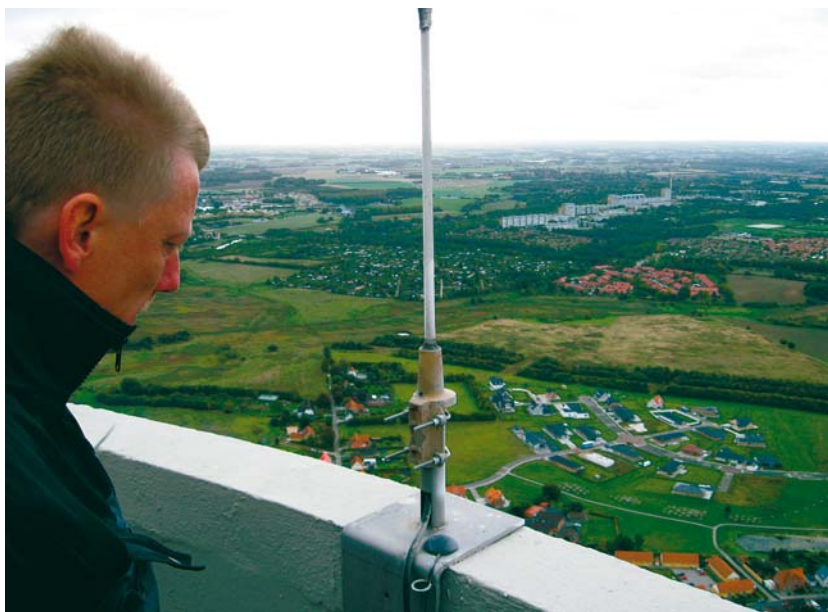
Lars Nielsen, OT Service ser ned fra skorstenen på Fynsværket, hvor antennen er monteret.
